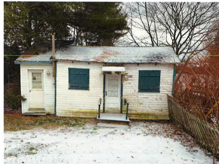
Bâtiment vétuste à acquérir et à démolir pour permettre l'aménagement du mini-parc riverain.
